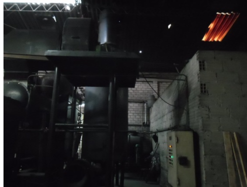
Foto 7 y 8. Caldera Dynaterm de 120BHP y sistema de control.
